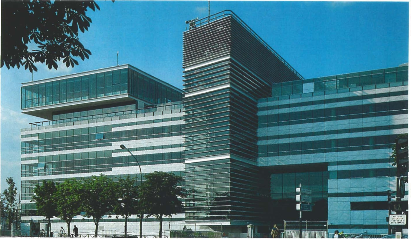
Façade côté boulevard du Général Martial Valin - Gril.
